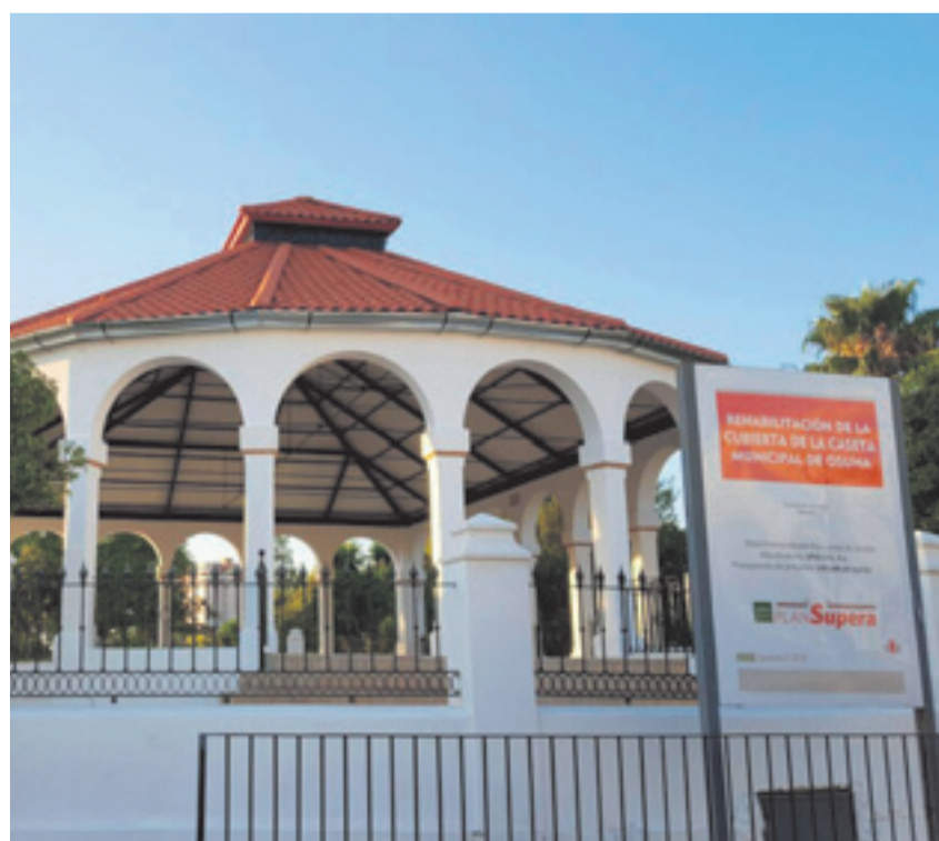
Ya ha concluido la primera fase de las obras de la caseta popular. / El Correo
