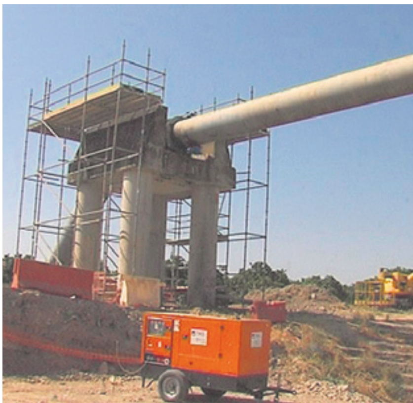
Obras para el desdoblamiento de la conducción del agua. /El Correo
