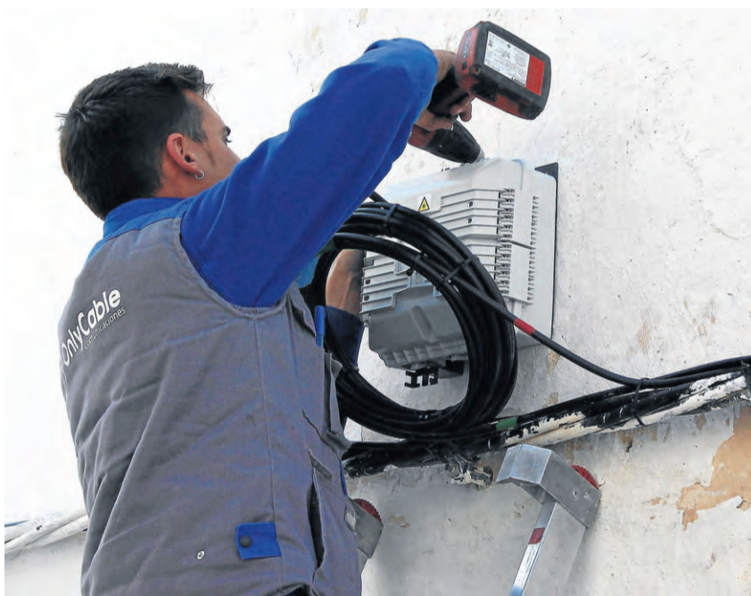
Uno de los profesionales que están instalando la fibra óptica. / El Correo
