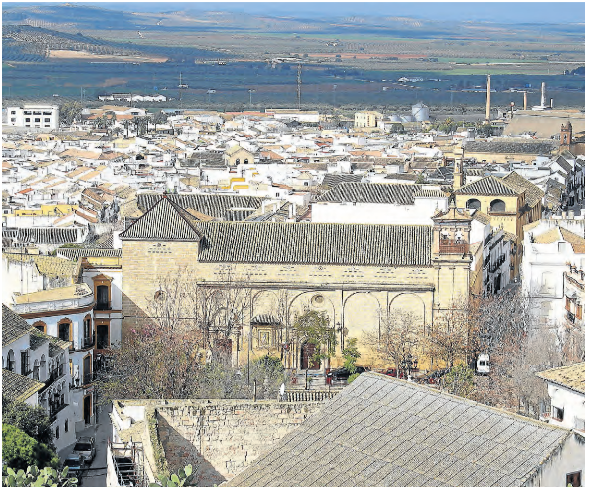
La fibra óptica estará completamente instalada a finales del próximo mes de agosto. / El Correo
